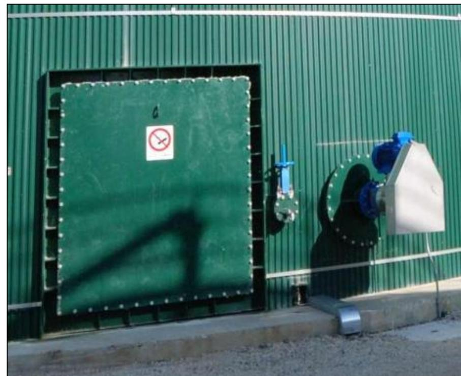
Per evitare perdite di calore importanti nei digestori, l'isolamento dei digestori avverrà con l'utilizzo di uno strato di lana di roccia di 15 cm. I digestori saranno riscaldati dal calore recuperato dal cogeneratore, dall'upgrading o da una caldaia a metano.
