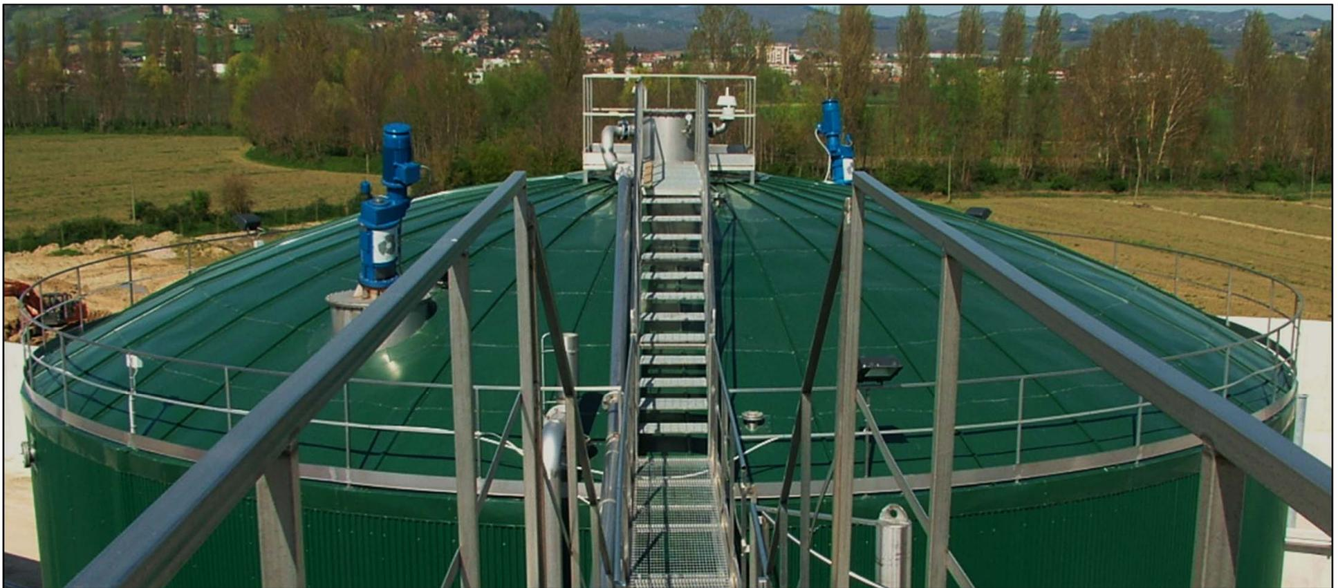
Il sistema di miscelazione adottato permette la totale manutenzione dei digestori esclusivamente dall'esterno evitando, in tal modo, il loro svuotamento in caso di intervento.
