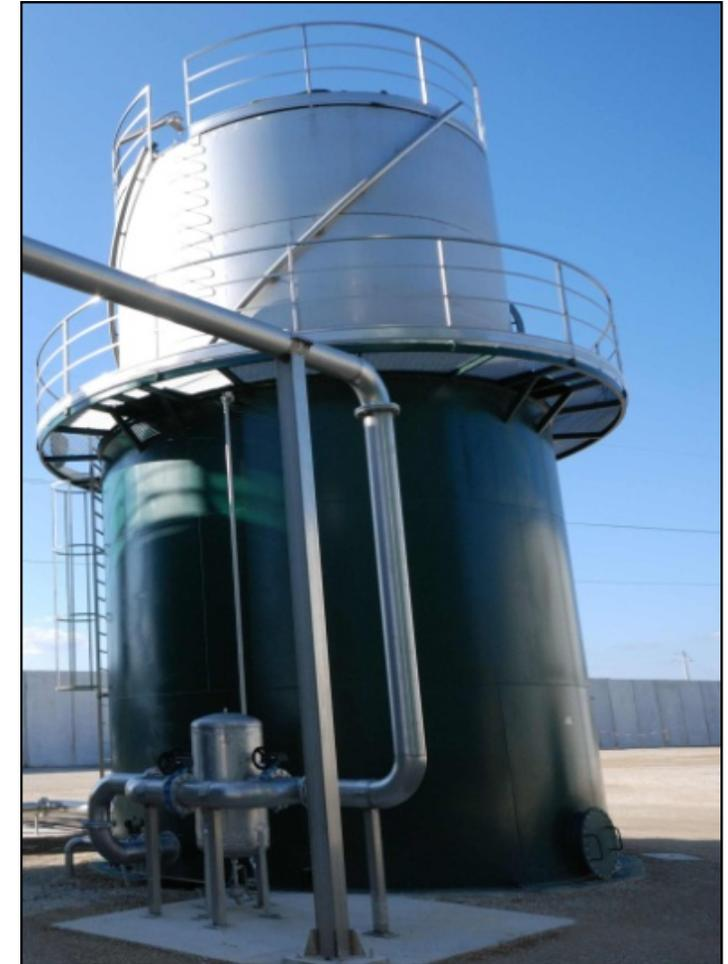
Il biogas prodotto dalla digestione anaerobica deve essere **deumidificato** e **desolforizzato** prima di essere inviato al sistema di upgrading. In questa prima sezione si ritrovano i seguenti elementi:
